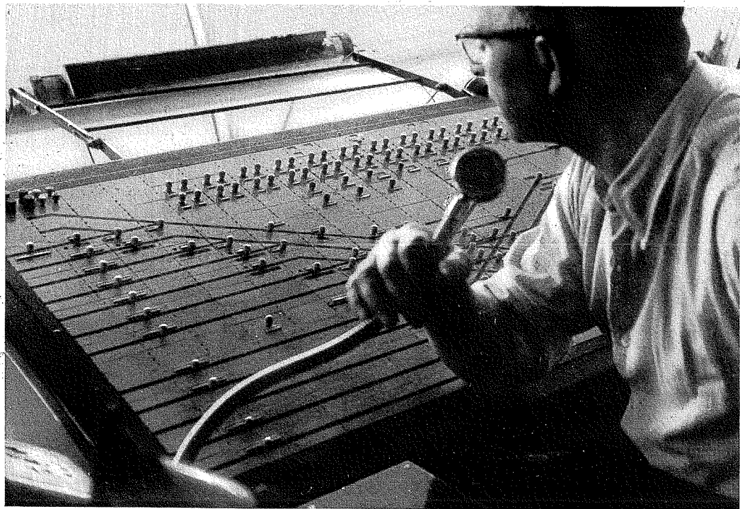
Il modernissimo quadro di controllo della stazione ferroviaria di Vienna
