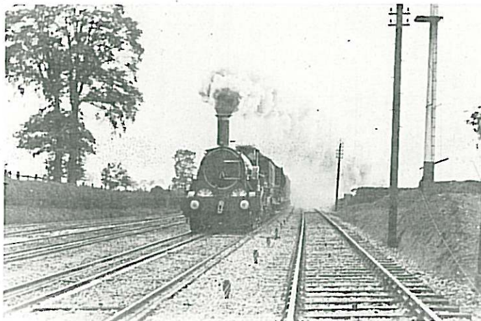
Fig. 2 - Linea a quattro binari di cui, quello a destra, già a scartamento standard (normale), munito del classico armamento inglese del binario del tipo a cuscinetti e rotaie a doppio fungo, e tre a scartamento misto, standard e largo (broad) ed armamento sistema Brunnel su longherine continue. Sul binario a fianco di quello standard, si avanza impetuosa ed imponente con il suo treno, una locomotiva «Broad Gauge» della classe «Rover» di cui parliamo nel testo. (Foto Loco publishing Company)
