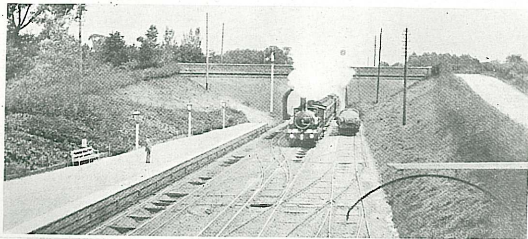
Fig. 6 - Una stazione su linea a scartamento largo del Great Western Railway, mentre transitava in esso un treno espresso rimorchiato da locomotiva 2-1-1 della classe, probabilmente, Rover. Osservate i due binari di corsa che erano muniti di una terza rotaia intermedia per permettere anche il passaggio del materiale a scartamento, definitivamente ormai, normale, mentre il binario di ricovero, anche esso praticamente a tre rotaie, era collegato al vicino binario di corsa con due comunicazioni indipendenti: una a scartamento largo ed una a scartamento normale. - La complessità dovuta alla coesistenza dei due scartamenti nelle linee e, soprattutto, nelle stazioni comuni, deve essere stata, ad un certo momento, veramente enorme, così da fare sollecitare la trasformazione allo «Standard Gauge» completata nel 1892. - La fotografia è del 1872 ed essa è stata riprodotta dal numero speciale della Railway Gazette dedicato al 1° Centenario delle Ferrovie. (Raccolta Zeta-Zeta)
