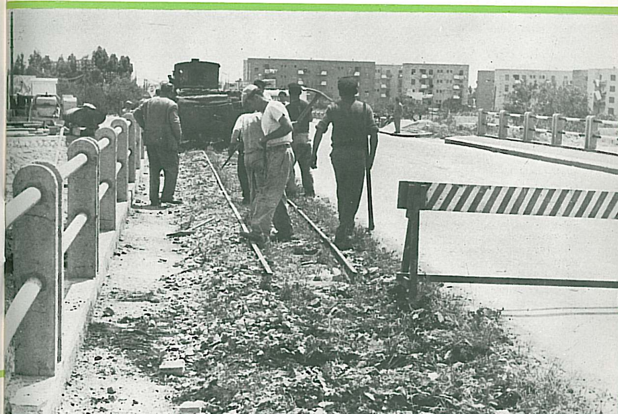
Sotto Si tolgono i binari che corrono presso la strada Statale n. 16 per aumentarne la carreggiata
