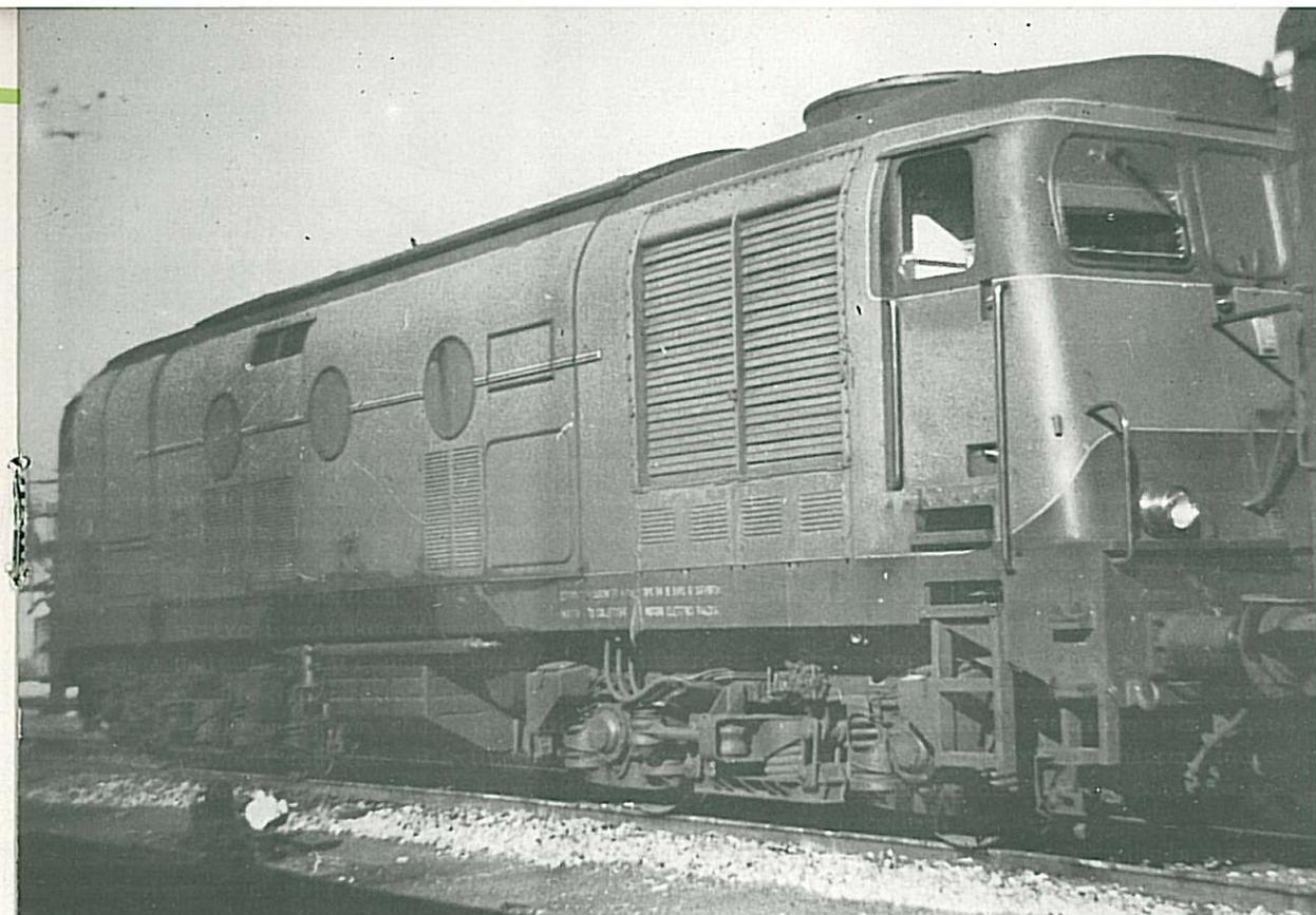
Fig. 5 - Motrice diesel-elettrica D.341 vista di fianco
