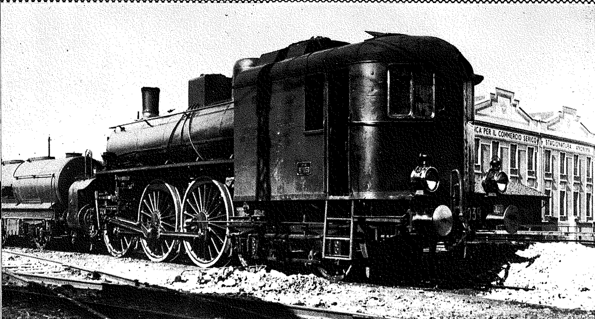
Locomotiva a 3 assi accoppiati e carrello anteriore (2-3-0) a vapore saturo e doppia espansione a 4 cilindri, 2 interni e 2 esterni. - Gruppo 670 F.S. (Già 370 - 500 R.A./690 F.S.)
