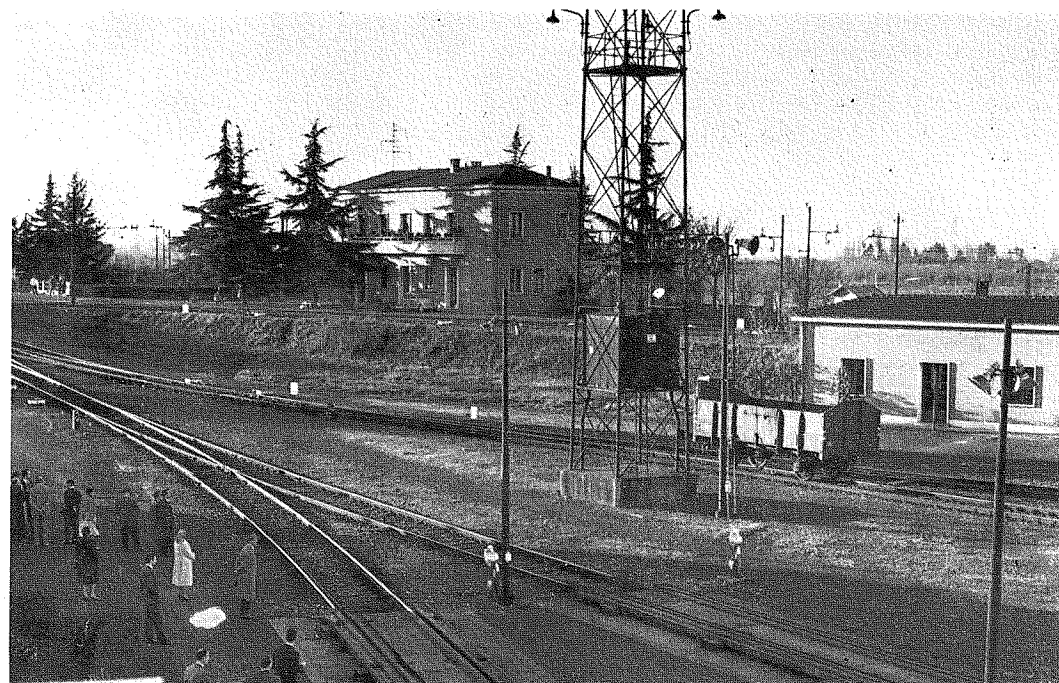
Fig. 2 Foto scattata alla rampa di Lancio dello scalo merci di S. Donato di Bologna. In primo piano si notino le due piattaforme per il rallentamento dei carri (Foto Veronese - Torino)
