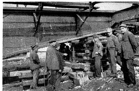
Fig. 6 Si cala la piattaforma già montata fino a farla appoggiare con le sue ruote sul circolo di rotolamento. Sorvegliano il funzionamento delle binde idrauliche il Capo Deposito Sig. Ferrara ed il Capo Tecnico Sig. Modesto. (Foto Zeta-Zeta)
