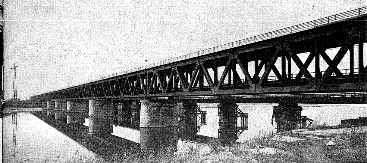
Fig. 10 Il ponte in ferro ferroviario e stradale sul fiume Po a Mezzanacorti nella sua sistemazione definitiva (Foto gentilmente offerta dalla Soc. Badoni di Lecco, costruttrice di cinque delle dieci travate indipendenti che, secondo i moderni criteri costruttivi, hanno sostituito l'unica travata continua progettata dall'Ing. Cottrau).
