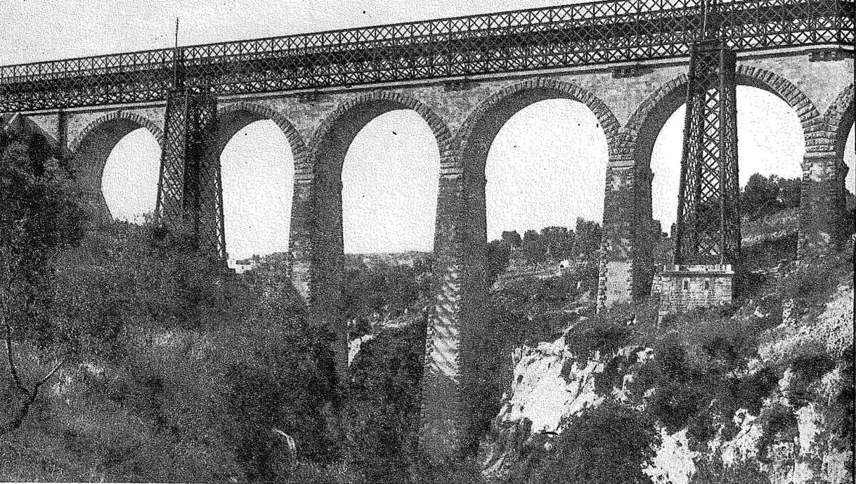
Fig. 4 Il vecchio viadotto in ferro di S. Stefano, visto in primo piano, e quello nuovo in muratura che lo ha sostituito. Osservate l'eleganza e l'arditezza delle stilate in ferro (Foto F.S. Raccolta Zeia-Zeta).
