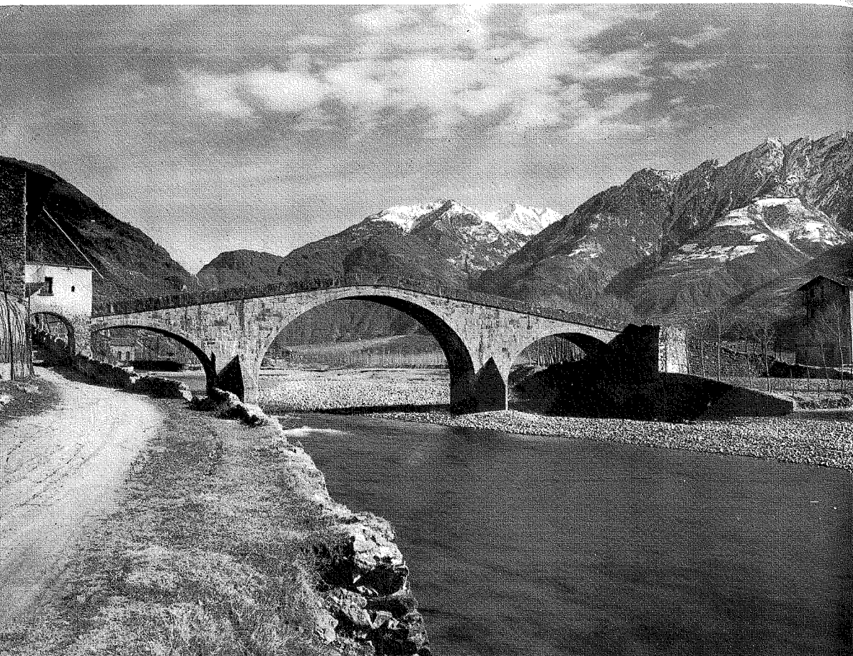
Fig. 1 Vista del vecchio ponte a schiena d'asino di «Gonda» sul fiume Adda, non lungi da Morbegno, ed unico mezzo, anche se piuttosto scomodo per accedere alla centrale elettrica alimentante la elettrificazione trifase delle linee valtellinesi (Foto Sella - F.S. Milano)
