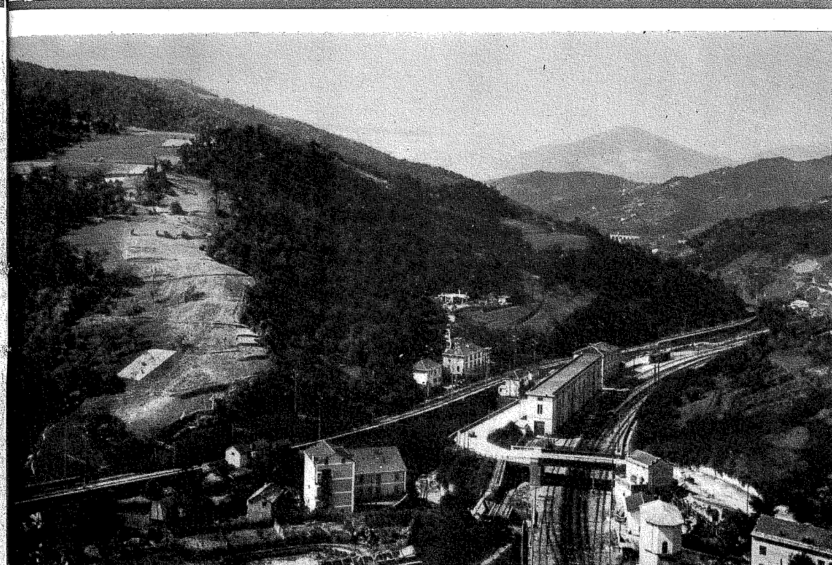
Fig. 4 Mignanego con le due linee dei Giovi viste dall'alto in direzione Nord Sud. A sinistra la rampa della vecchia linea dei Giovi di cui alla precedente riproduzione della stampa del Bossoli. Si intravede il ponte sul torrente Riccò. A destra la stazione di Mignanego e la linea succursale dei Giovi che ha raggiunto con moderata pendenza costante l'imbocco Sud della galleria di valico lunga m. 8.297,55.
