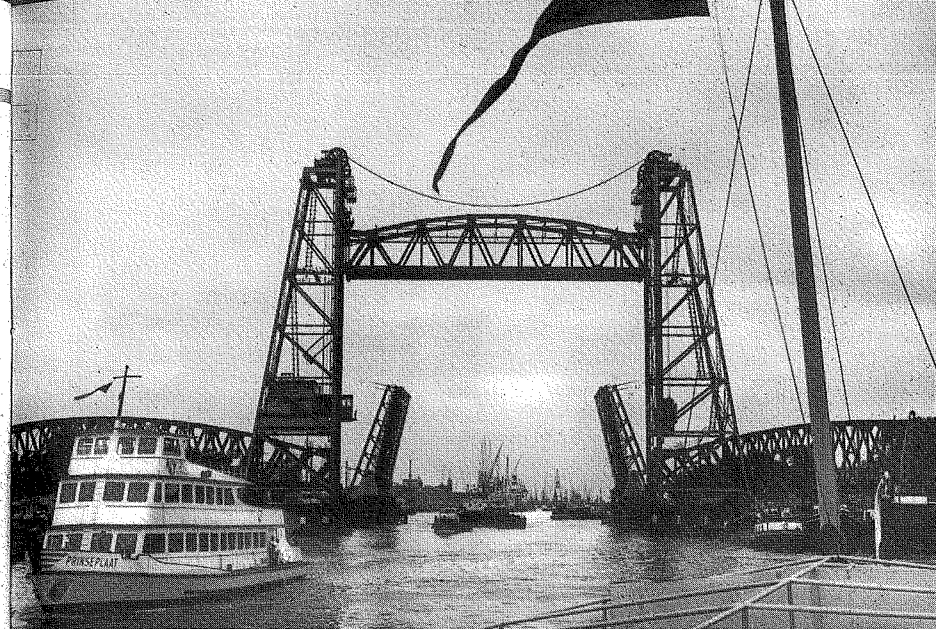
Fig. 6 Olanda - Congresso Morop 1964. Bacino del porto di Rotterdam: ponte ferroviario aperto per il passaggio dei vapori. (Foto Veronese - Torino).
