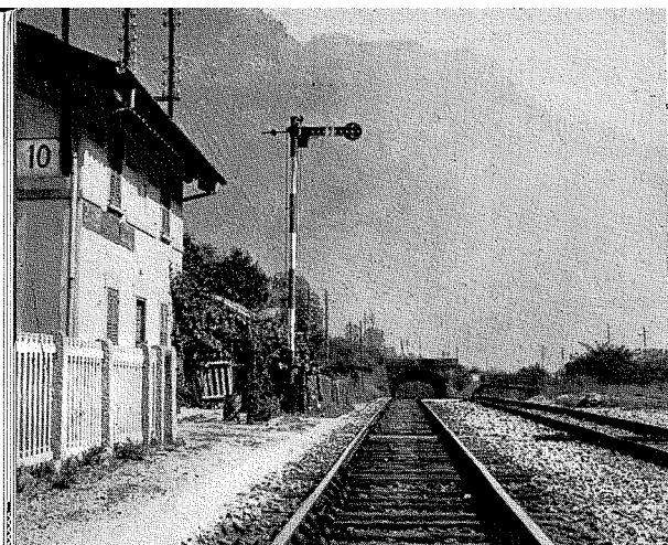
Fig. 25 Uscita dalla stazione di Varzo verso Domodossola (anno 1929). In secondo piano segnale di partenza rispondente al regolamento dei segnali in uso in quell'epoca presso le Ferrovie Federali Svizzere. Armamento del binario, quale si vede in primo piano, di tipo inglese a cuscinetti con rotale del tipo R.M. pesanti Kg. 47,2 al metro lineare appositamente studiate per la linea Domodossola Iselle dal Valtellinese Ing. Luigi Zanotta, capo dell'Ufficio Armamento della Rete Mediterranea. (Osservate come dopo il breve percorso quasi in piano nella stazione di Varzo la linea precipiti in discesa verso Domodossola (Foto Zeta-Zeta, Varzo anno 1929).
